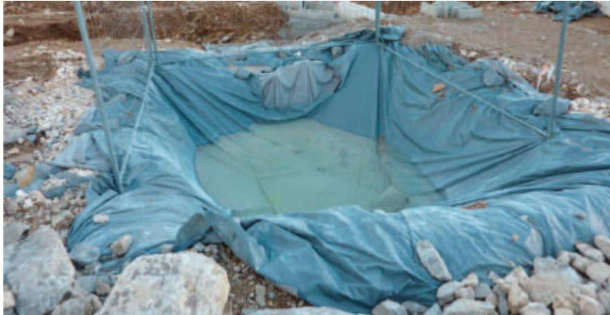
Figure 89 : Exemples de fosses étanches de récupération des résidus de nettoyage des goulottes des toupies béton.
