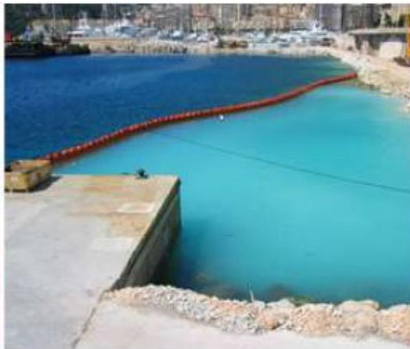
Figure 94 : Exemple de mise en place d'un écran anti-turbidité en mer
