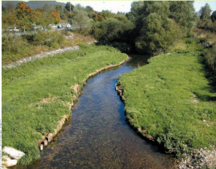
**Figure 114 : Exemple de représentation d'un chenal d'étiage dans le lit mineur d'un cours d'eau élargi**
